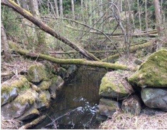
Den gediget byggda bassängen där vattenhjulet stått. Den är 10 m lång och 2½ meter bred. Höjden från botten till övre delen av stenarna är ca 1,5 m.
